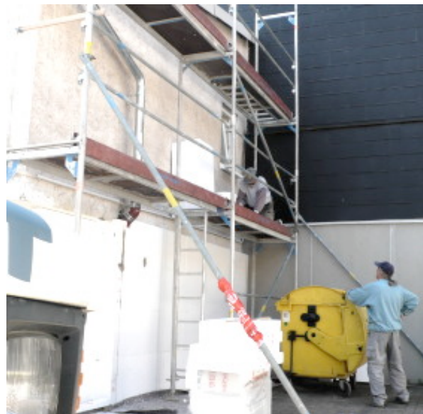
Mitglieder des Arbeitsteams bringen die Wärmeisolierung am Seitengebäude an.
